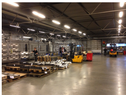
Tunneltvätt med hängconveyor samt kedjebana om 5 steg
