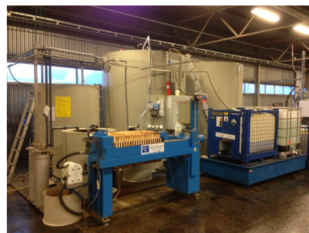
Reningsverk för spillvatten
