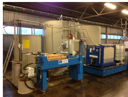
Reningsverk för spillvatten
